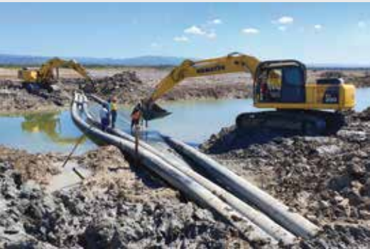
Instalasi Pipa HDPE, Pintu Air, dan Aksesoris untuk Ladang Garam PT Inti Daya Kencana, Weoe, Kab. Malaka, Nusa Tenggara Timur
