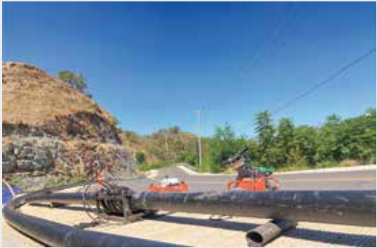
Pembangunan Jaringan Perpipaan SPAM Wae Mese II Labuan Bajo, Kab. Manggarai Barat, Nusa Tenggara Timur
